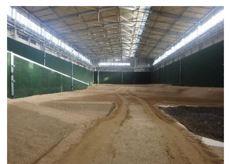
▼埋立施設内部
