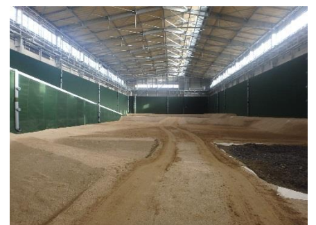
▼埋立施設内部
