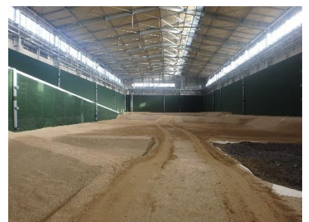
▼埋立施設内部
