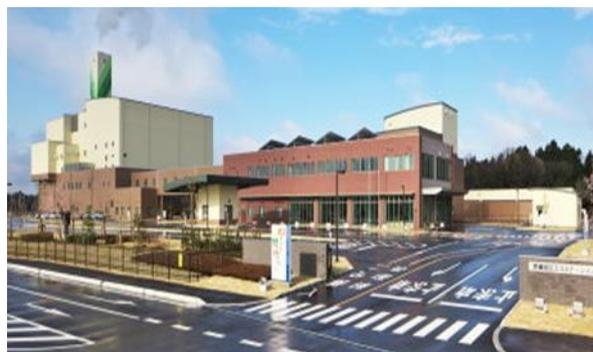
熱回収施設は、ごみ焼却設備に「流動床式ガス化溶融炉」を導入し、ごみを効率よく安定処理するとともに排ガス中の有害物質の除去、最終処分量の削減を図り、また、余熱を利用した発電、焼却灰のスラグ化、鉄類、アルミ類などの資源の回収を図っています。
