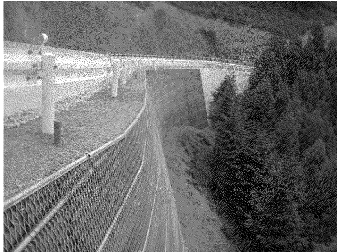
図1-1-1 補強盛土の適用事例
