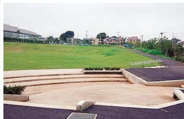
■柏市第2清掃工場&かしま環境ステーション(多目的広場)
