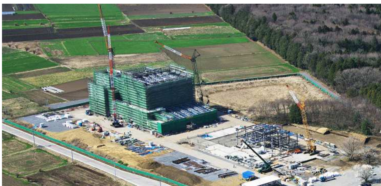
左側：熱回収施設
